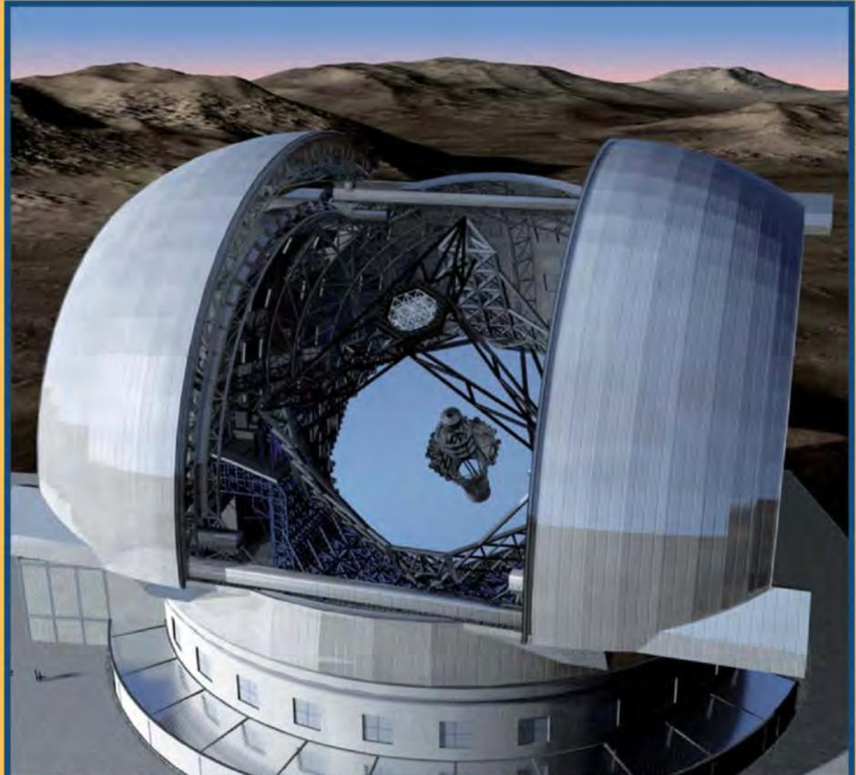
Image du futur télescope Européen E-ELT. Son miroir principal d'un diamètre de 42 mètres sera composé d'un assemblage de miroirs hexagonaux de 5 cm d'épaisseur placés sur un berceau de 1000 vérins capable de changer la forme du collecteur plusieurs centaines de fois par seconde. *Source ESO*
